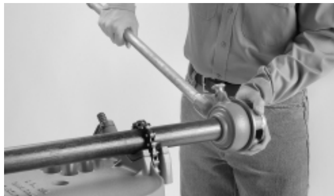
Figure 3 – Montage de la fileteuse sur le tuyau
